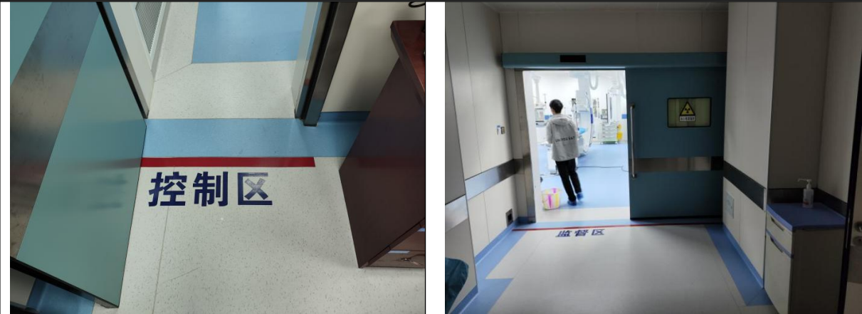
两区实际建设情况
